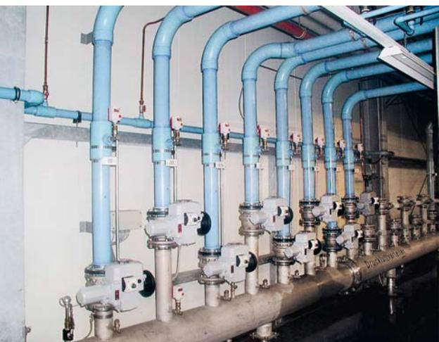
*Rohrverbindungen löten, schweißen und kleben – das empfiehlt Metapipe-Geschäftsführer Karl-Heinz Feldmann. Denn spalthaltige Verbindungen mit Gummidichtungen bergen die Gefahr in sich, über Jahrzehnte undicht zu werden.*
